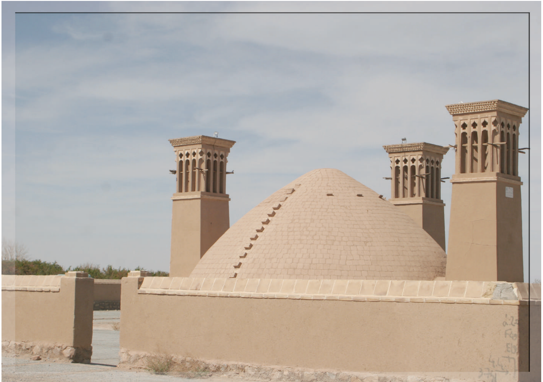
یزد، روستای زین آباد – آب انبار با بادگیر
